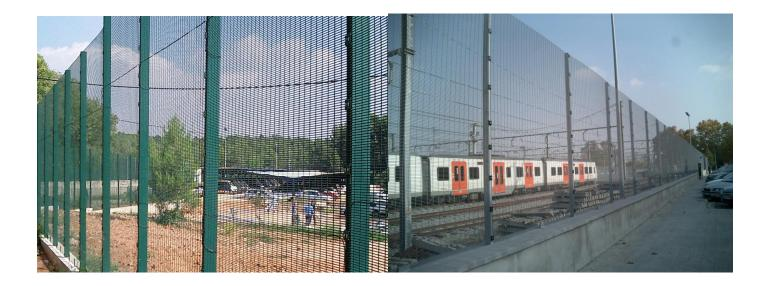
Paneles en 2.00, 2.40, 3.00, 3.65, 4.00, 4.70, 5.30, 6.00 m de alto y 2.52 m de ancho.
